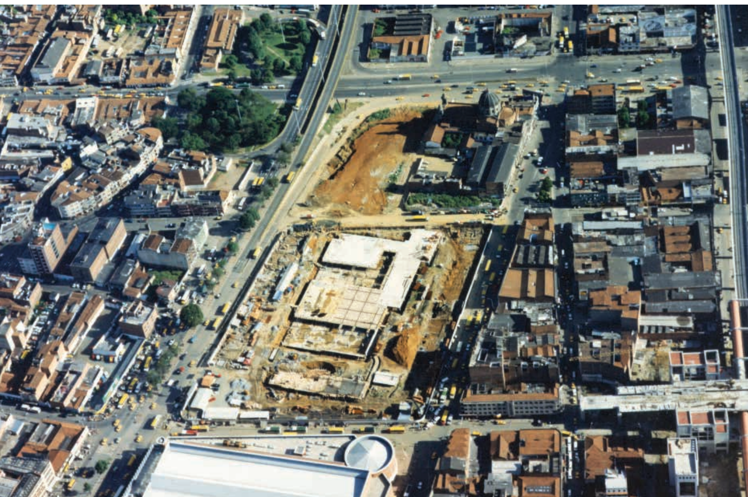
› Fotografía aérea de la construcción del Parque San Antonio. S. f.
