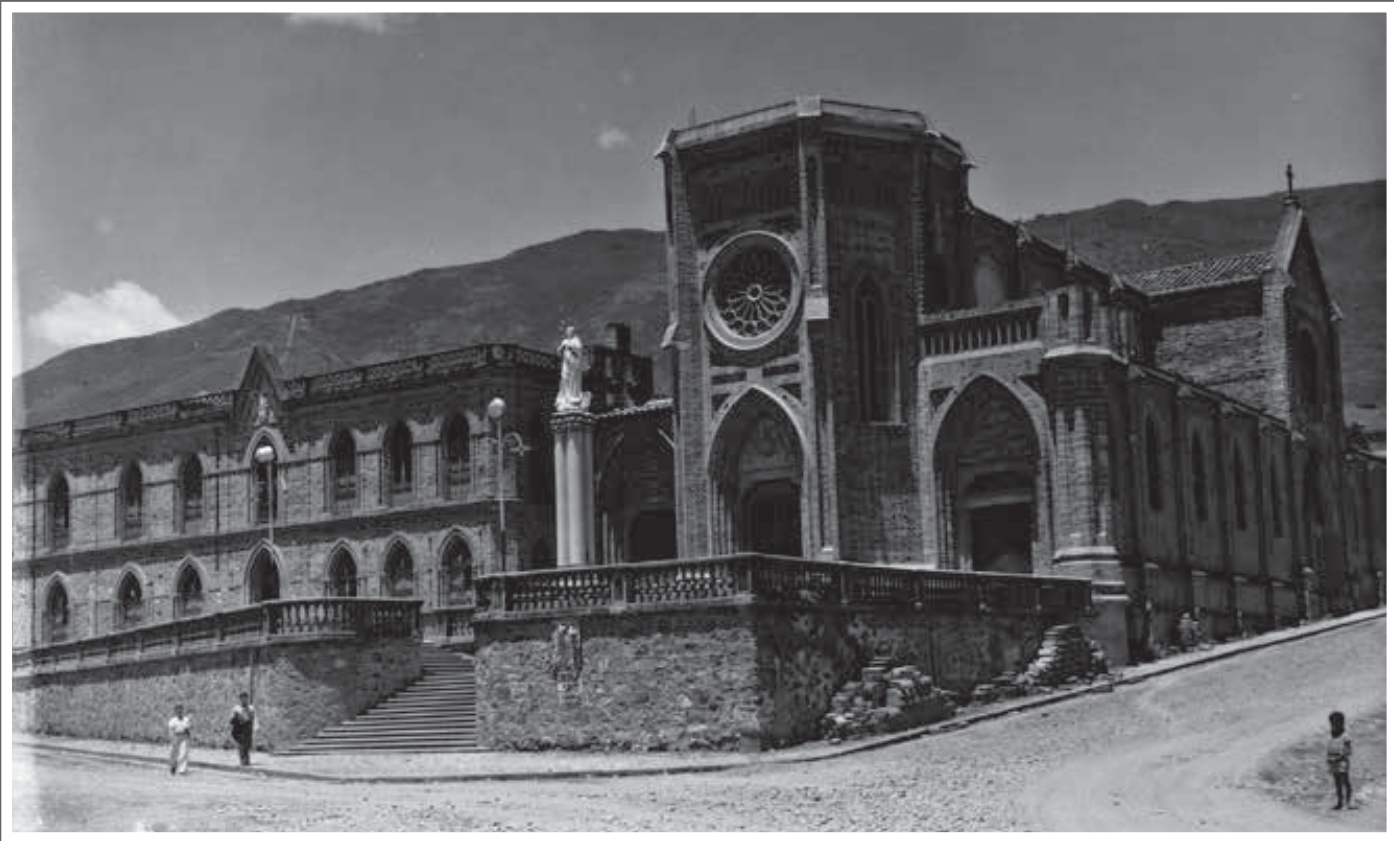
Iglesia de Manrique en construcción, 1941.
